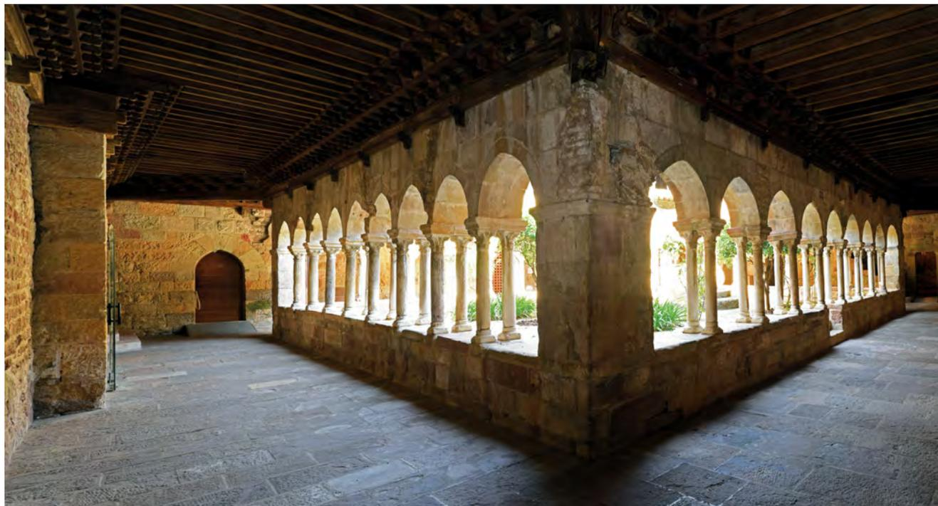
belles galeries d'apparats. Sa voûte en pierre est supprimée et remplacée par un plafond en bois de mélèze, choisi pour sa résistance. De chaque côté de la galerie, les boiseries sont placées en encorbellement sur trois rangées. Entre les solives de plancher, pièces de charpentes reposant sur les poutres, des rangées de planchettes sont disposées. Elles sont peintes avant d'être assemblées pour former un plafond unique.
